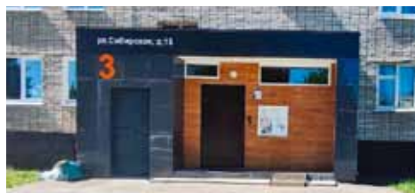
Фасад дома после ремонта
