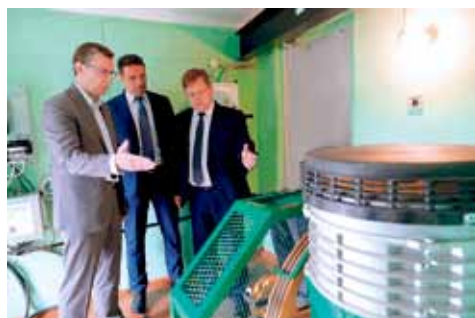
Демонстрация лифтового оборудования в машинном отделении председателю правительства УР Я. В. Семёнову и министру строительства, архитектуры и жилищной политики УР Д. Н. Сурнину.
